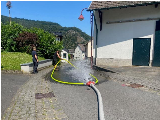
Abb. 5: Dotierversuche mittels Hydrant und Schläuchen (Bild: G. Stratmann)
